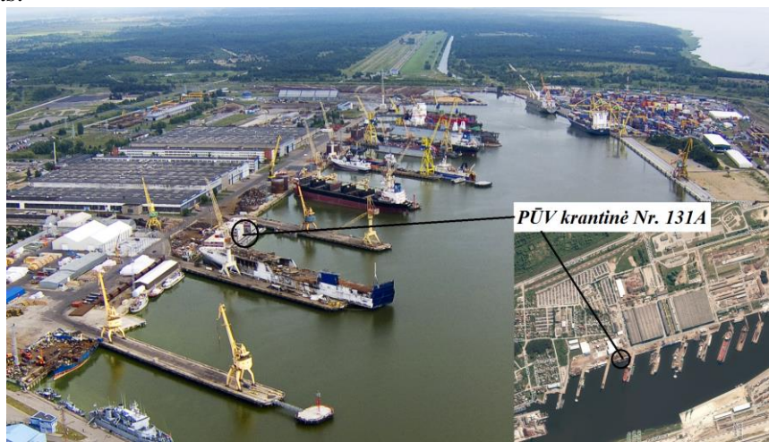
PŪV krantinės Nr. 131A panoraminis vaizdas
